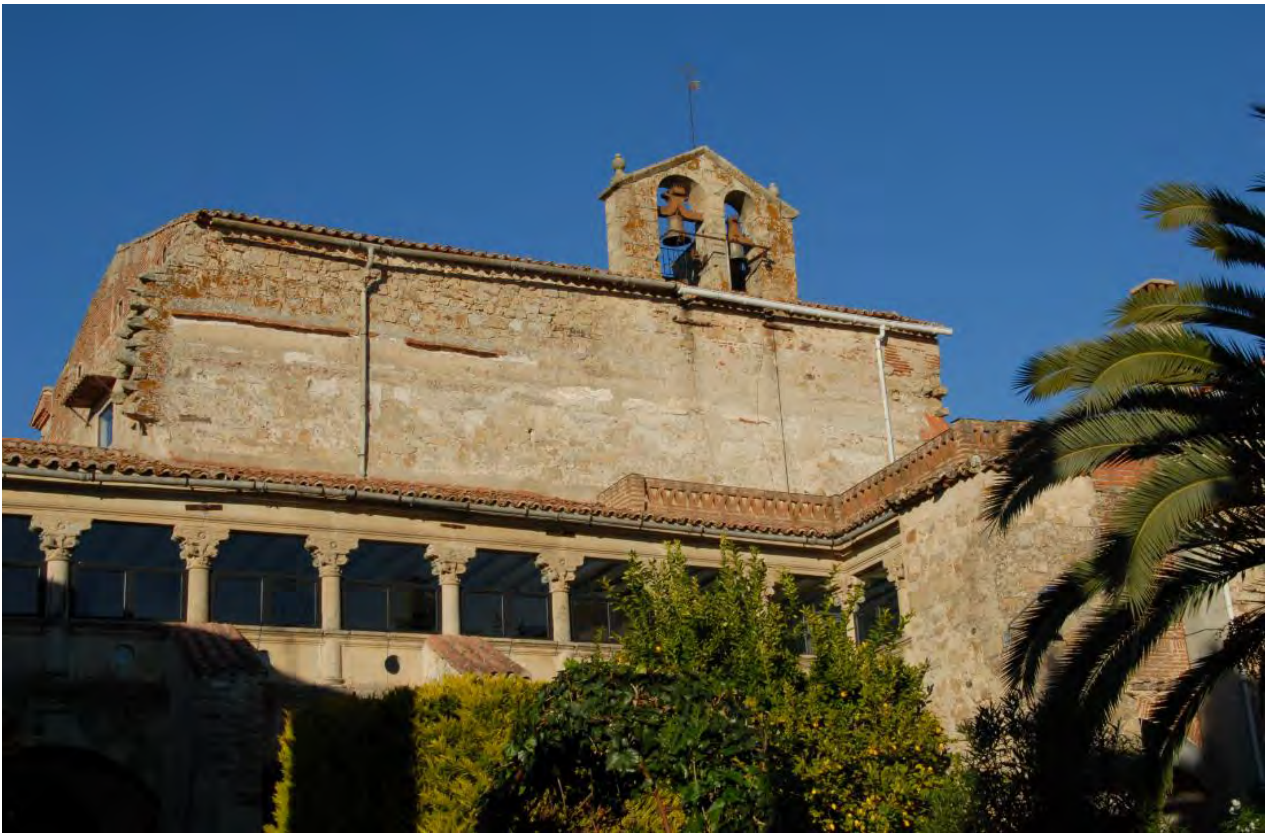
Detalle de la portada del primitivo convento en la Calle Tintoreros
