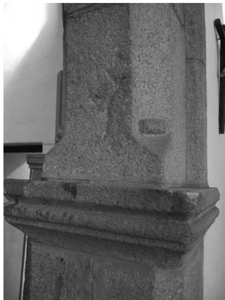
10. Restos Góticos en los pilares.
