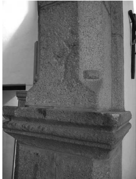
10. Restos Góticos en los pilares.
